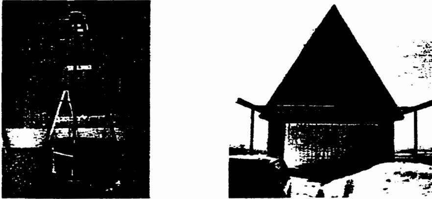
Figure 61: Bâtiment de l'observatoire de Malcolm Knapp Research Forest. À droite, vue intérieure avec le 2.7 m de UBC-UL installé. À gauche, façade nord avec les rails du toit roulant et la grande porte de la coupole.
