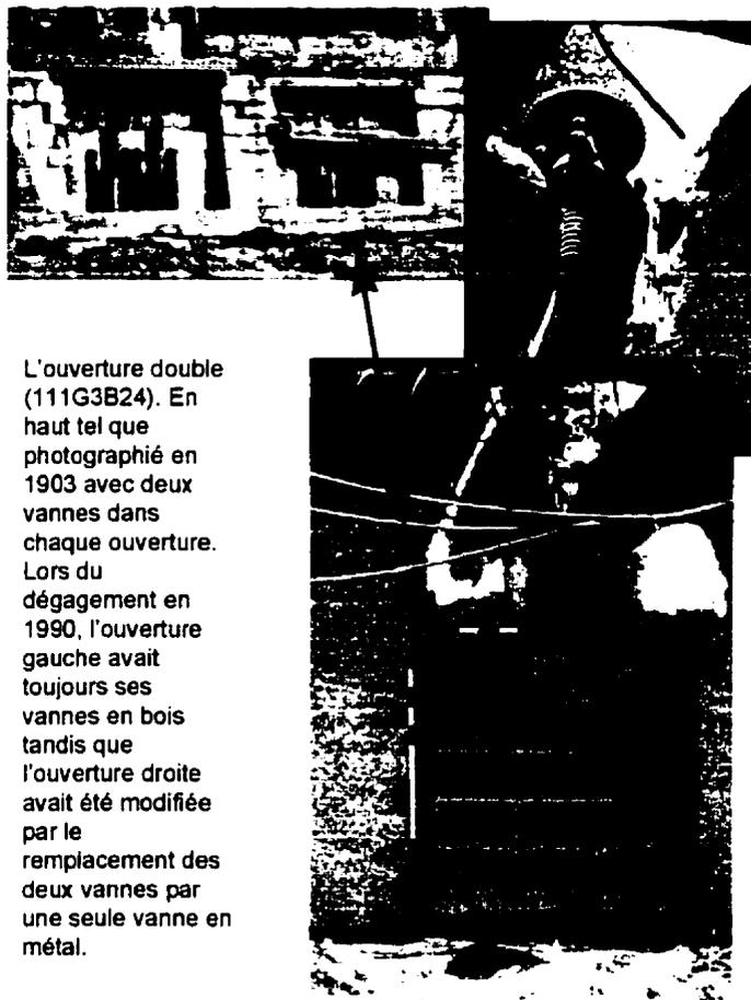
L'ouverture double (111G3B24). En haut tel que photographié en 1903 avec deux vannes dans chaque ouverture. Lors du dégagement en 1990, l'ouverture gauche avait toujours ses vannes en bois tandis que l'ouverture droite avait été modifiée par le remplacement des deux vannes par une seule vanne en métal.
