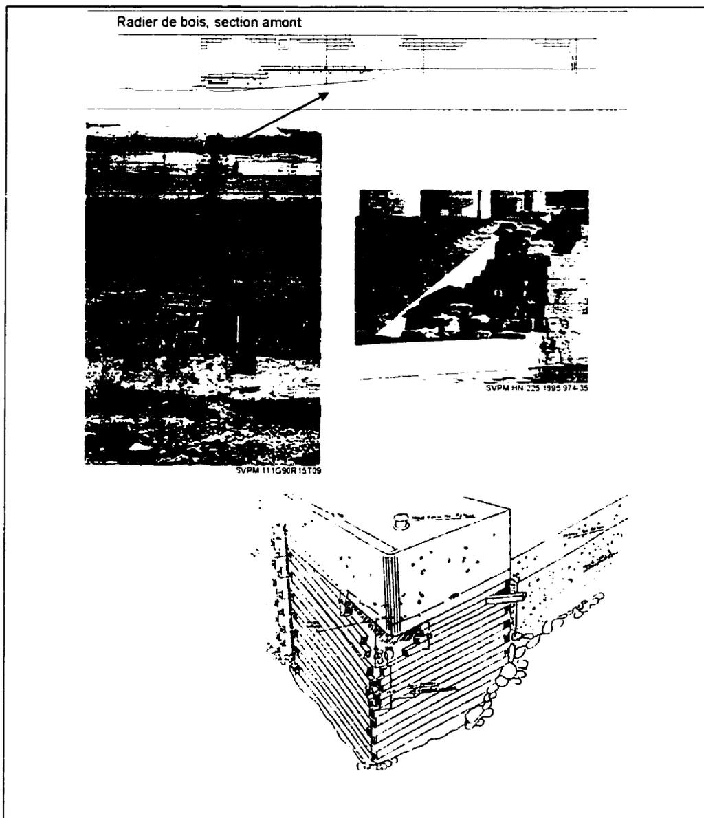
Deux sections d'un **quai en bois** ont été retrouvées au centre de la jetée entre les écluses 1 et 2 (Figure A-24). La portion nord forme un angle et constitue la limite aval de cet ancien quai. La portion sud est linéaire. Le type de construction semble identique dans les deux segments et montre que ce quai était constitué de sections juxtaposées. La façade est composée de pièces sur pièces de 0,30m x 0,30m et de 5 à 6 mètres de long. Les pièces de bois sont jointes par
