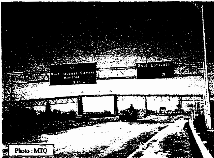
Figure 1-1 :Portique de signalisation aérienne en aluminium
